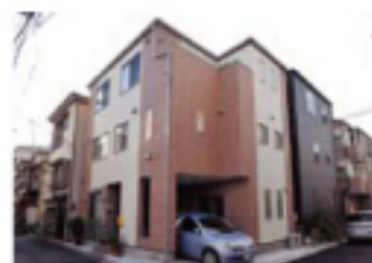
敷地20坪に建つ2世帯住宅。1階にはお母様のお部屋と、車庫の他、K様の仕事場も設置
